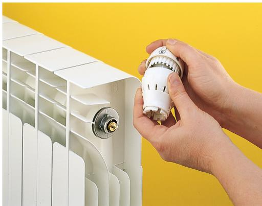
Después de haber colocado el volante en la posición deseada insertarlo ejerciendo una ligera presión manual o utilizar un utensilio adecuado. Por ningún motivo forzar la posición del bulbo, para evitar la pérdida de tarado del cabezal termostático.
